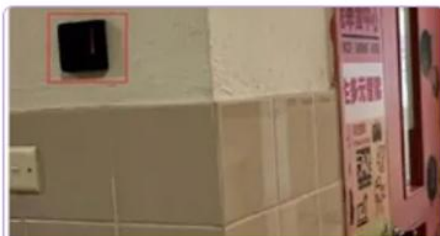
圖2：三樓走廊近C梯
